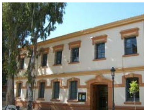
Fachada de entrada al edificio
