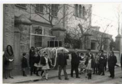
Fachada del Convento donde se observa el muro que lo rodeaba durante la sepultura de una de las religiosas.
